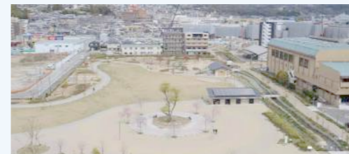
キセラ川西せせらぎ公園(キセラ川西PFI事業) 兵庫県川西市
