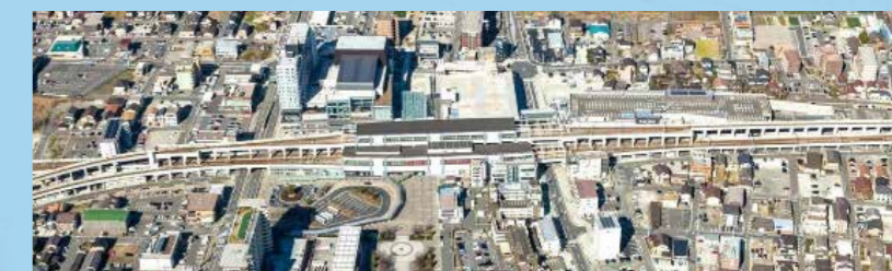
高架化した太田川駅
