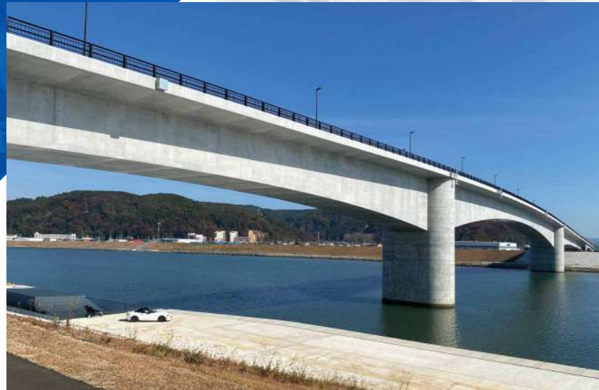
石巻かわみな大橋 宮城県石巻市
