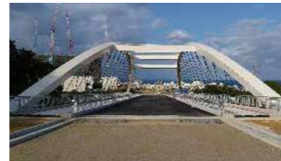
安仁屋橋 沖縄県宜野湾市
