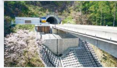
災害復旧:権兵衛峠 長野県上伊那郡南箕輪村
