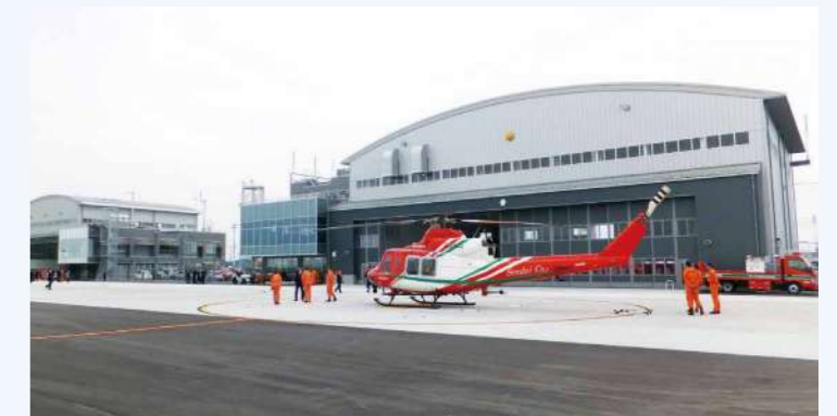
宮城県・仙台市消防航空隊庁舎及び格納庫 宮城県岩沼市
