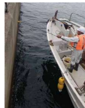
港湾施設の点検・維持管理
