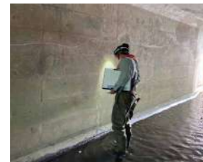
施設点検の状況
